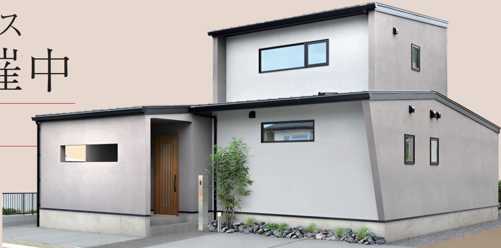
※掲載の写真の外構はCGベースは図面を基に描いたもので、実際とは多少異なる場合があります。
